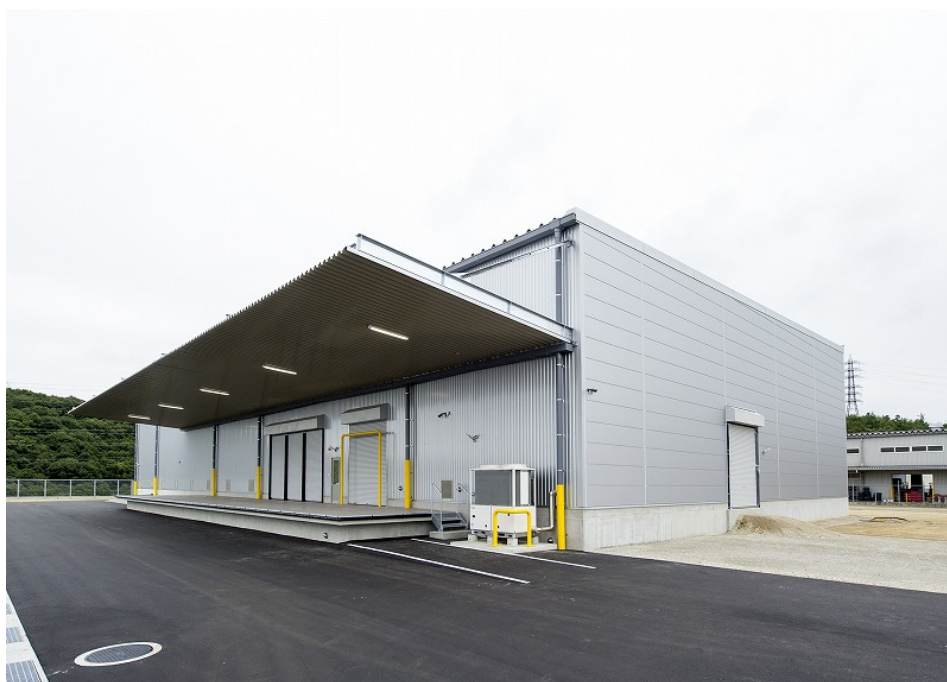
物件名／「(仮称) ㈱朋昆新冷蔵倉庫新築工事」 建設地／広島県尾道市 用途／倉庫 商品名／トレオ 平屋／施工床面積／1,652㎡ 建築主／株式会社朋昆様 設計者／有限会社共和設計様 施工／山陽建設株式会社様 特記／盛土式プラットホームの冷凍・冷蔵倉庫。低コスト・短工期が評価された。
