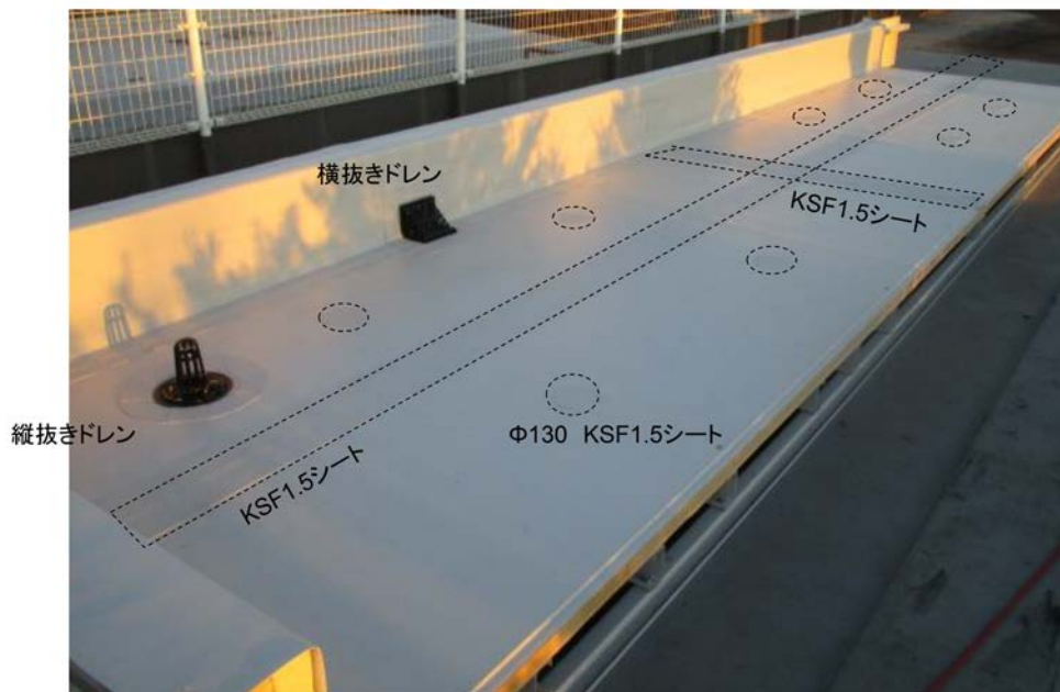
フラットルーフの試作試験状況
